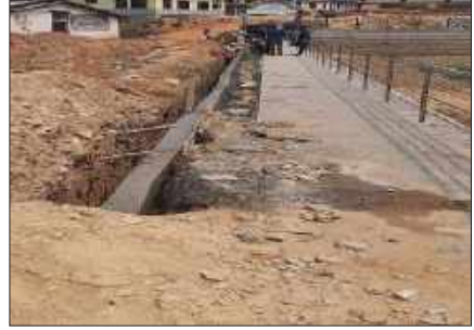
चुहावट रोक्ने निर्मित टेवा पर्खाल, पर्वत
